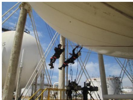
a) Kiểm tra chất lượng bồn thủ công ở Việt Nam b) Kỹ thuật viên kiểm tra chất lượng bồn với thiết bị thủ công
