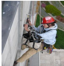
Hình 1: Kiểm tra mòn thực hiện thủ công [2]
